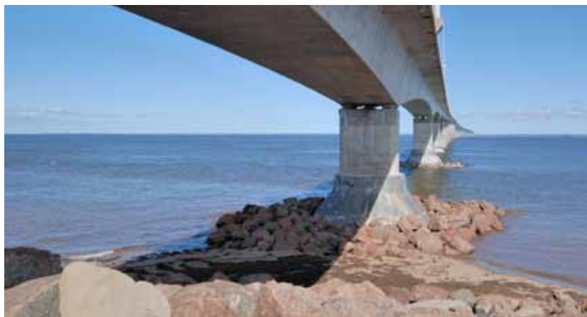
Рис. 3. Фото моста Конфедерации в Канаде, смонтированного из большеразмерных железобетонных пустотелых коробчатых балок, стянутых в магистраль стальными канатами по технологии post-tension и опирающихся на колонны. Расстояние между осями опор 250 м. Высота магистрали над водной поверхностью около 50 м
