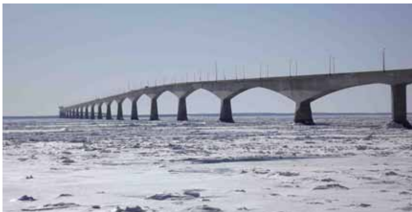
Рис. 2. Крупногабаритные железобетонные пустотелые коробчатые балки для транспортных магистралей
