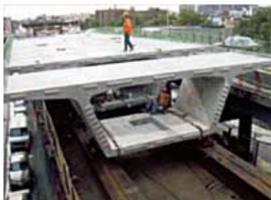
Рис. 2. Крупногабаритные железобетонные пустотелые коробчатые балки для транспортных магистралей
