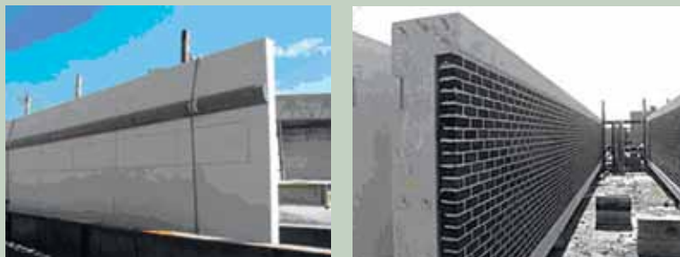
Рис. 4. Железобетонный пустотелый элемент скоростной автомобильной восьмирядной трассы при транспортировке на место строительства. Видны отверстия для ввода стальных стягивающих канатов при сборке элементов в единую эстакаду
