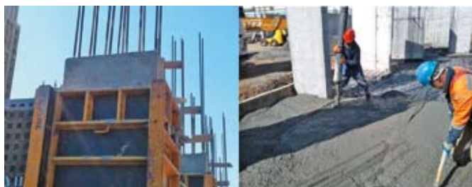
а). Опалубка 1-2 объекта для заливки бетона на наноцементе 55 б). Подача бетона автобетононасосом. Укладка бетона без виброуплотнения
