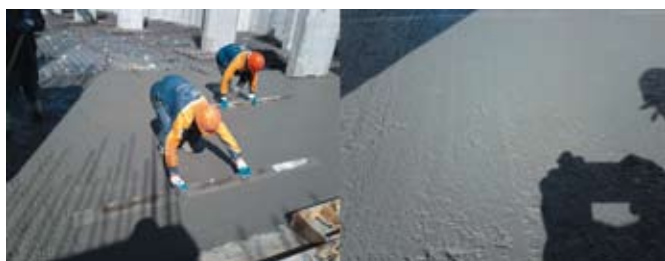
а) Разравнивание бетонной смеси б) Бетонная смесь после разравнивания
