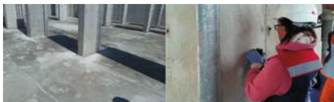
д) Вторые сутки после снятия опалубки е) Снятие показателей прибором ИГП
