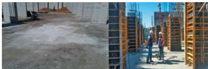
в) Первые сутки после заливки г) Состояние через сутки твердения
