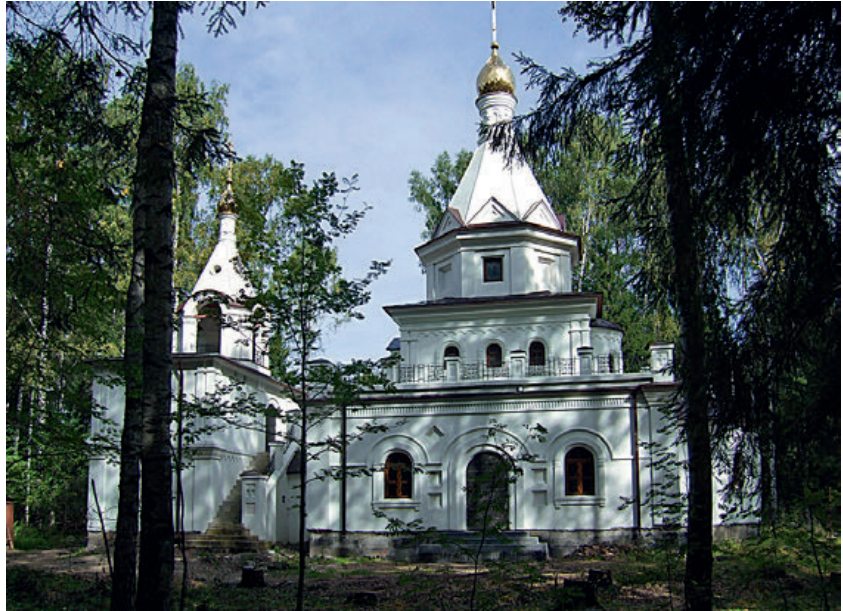
Рис. 2. Храм Всех Святых в г. Дубне Московской области. Купола церкви толщиной 40 мм выполнены из наноцемента. 2005 год
