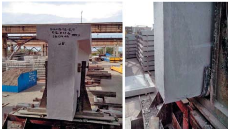
Рис. 4. Железобетонные конструкции ТОО «Стройдеталь», обработанные ремонтным составом на основе наноцемента 75
